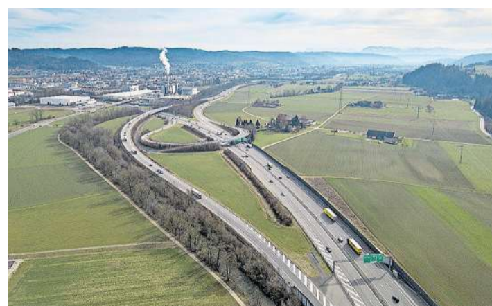
Auf Bundesterrain in der Autobahnschleife Wiggertal entstehen Lager, Werkstatt und Teststrecke für die Brücke. Bild: Michael Küng
