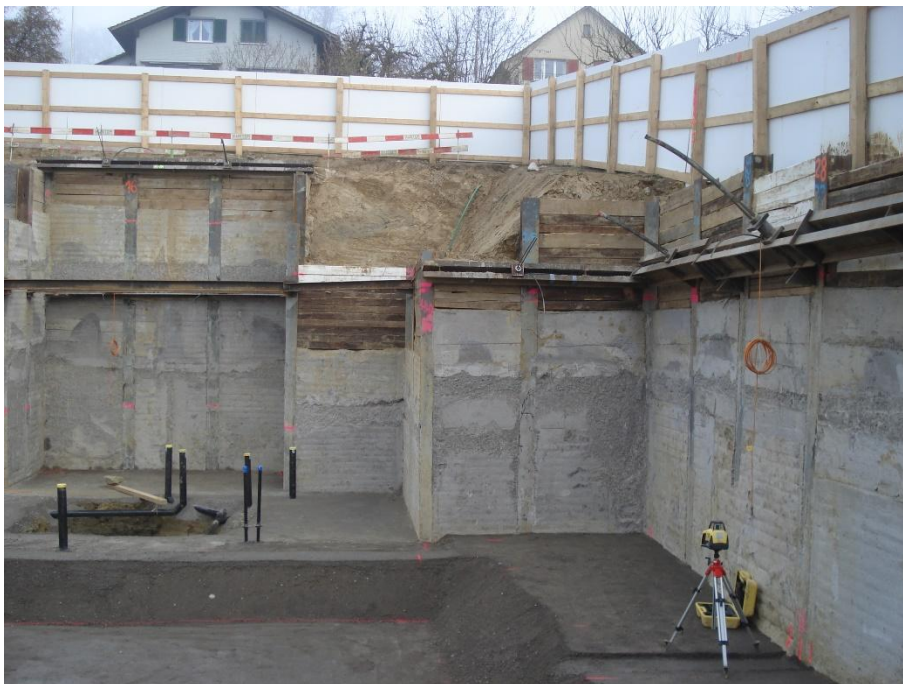
Erstellte Baugrube mit gespriesster und rückveran- kerter Rühlwand
